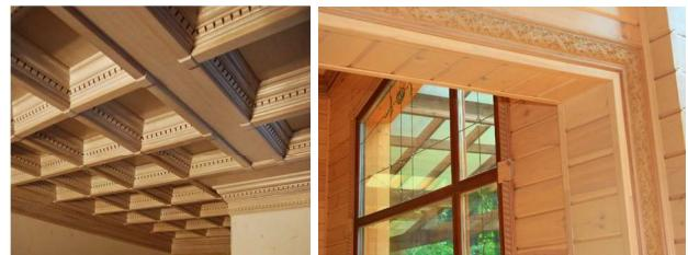
Раскладка – изящная рейка скрывает погрешности монтажа, облицовывает кромки, декорирует щели.
