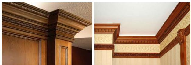
Карниз – предназначен для декорирования места стыка потолка и края обоев на стене, создает красивый акцент.
