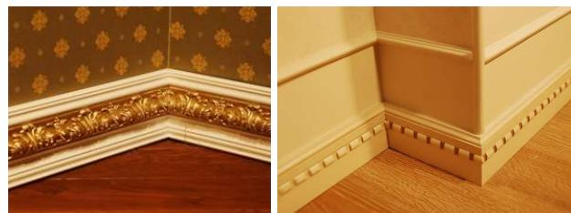
Плинтус – профилированная планка, закрывающая щель между стеной и полом.
