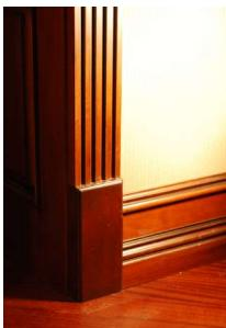
Плинтусный блок стыкует наличник двери и плинтус под углом 90°, «солдатик» стыкует плинтус по длине, в углах внешних и внутренних.
