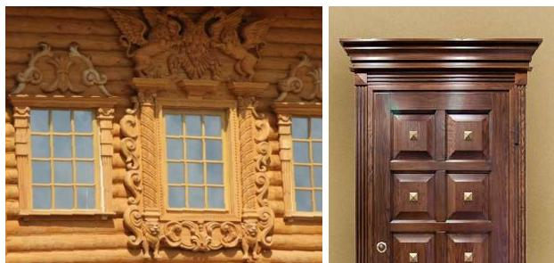
Наличник – фигурная накладная планка, для обрамления дверных, оконных проемов и ниш.
